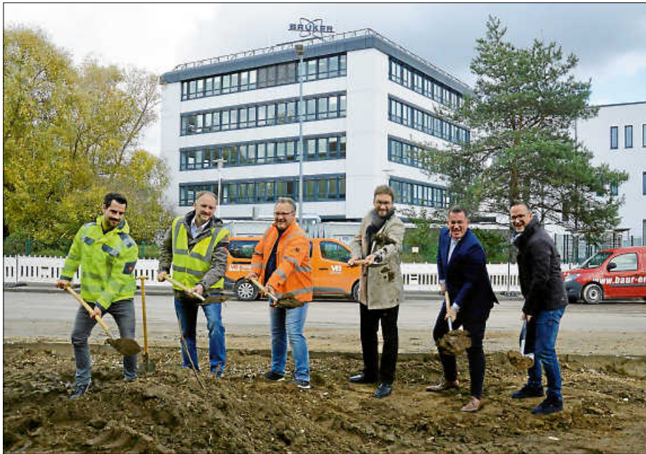
Beim Spatenstich für den durch eine Ampel gesteuerten Verkehrsknotenpunkt: Patrick Niedau vom Ingenieurbüro Fichter, Tiefbauer Wagner, Projektleiter von Vogel-Bau Dirk Hartmann, BM Heidecker, Bruker-Geschäftsführer Minhorst und Mitarbeiter Schmalz (v. l. n. r.)
