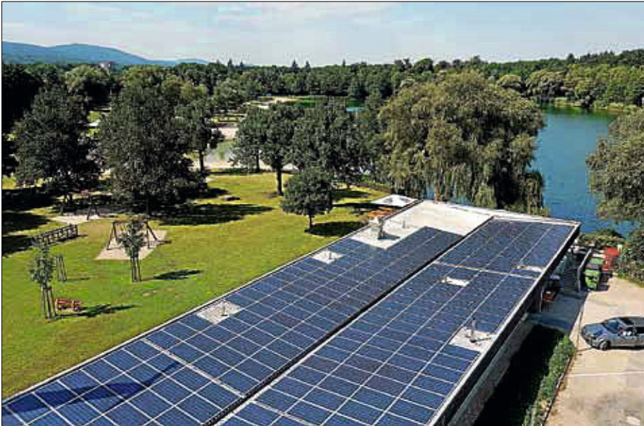
Die Photovoltaikanlage auf dem Sanitärtrakt des Buchzig Sees sorgt für eine 50-prozentige Steigerung beim Ergebnis für das Jahr 2017.
