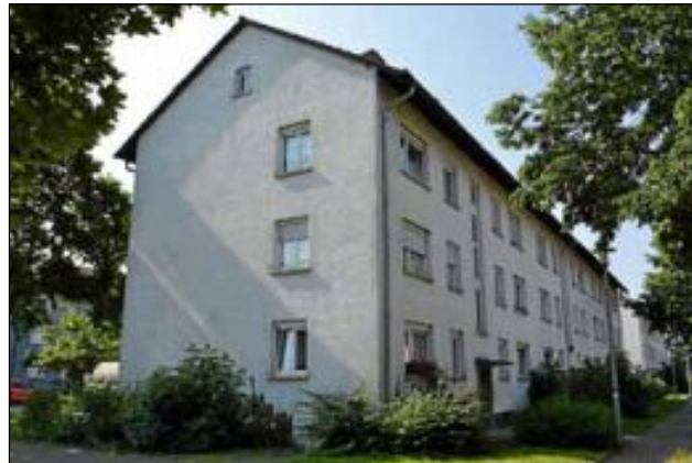
Das nächste große Sanierungsprojekt der Stadtbau ist im Pappelweg (siehe Bild) und im Josef-Stöhrer-Weg in Ettlingen-West.
