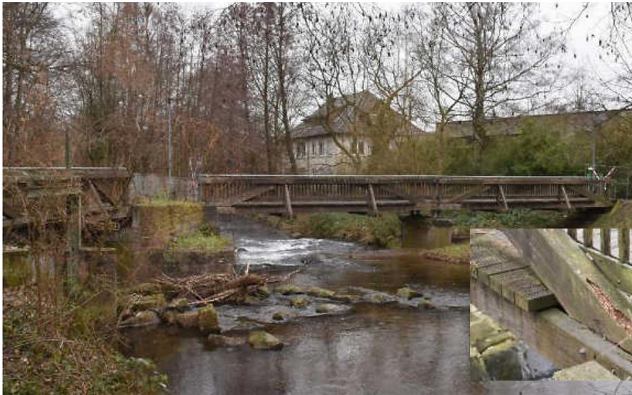
An der Bulacher Straße überspannt eine Brücke die Alb (im Foto rechts), ein weiteres Brückenbauwerk nebst Wehr, genannt ETO-Wehr, quert den dort von der Alb abzweigenden Erlengraben (ganz links im Bild zu sehen). Die Albbrücke war im Dezember 2021 wegen konstruktiver Mängel gesperrt worden. Der Gemeinderat beschloss einen Neubau, geschätzte Kosten rund 650.000 Euro. Das Detailbild zeigt einen der maroden Balken.
