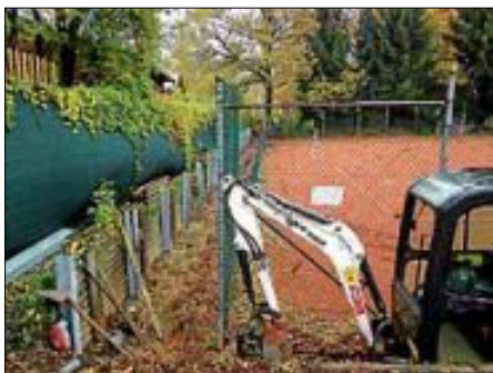
Im Herbst führt der TCE wieder zahlreiche Sanierungsarbeiten durch. Im Bild Arbeiten für die neue Wand an der Geländegrenze zum Kindergarten.
