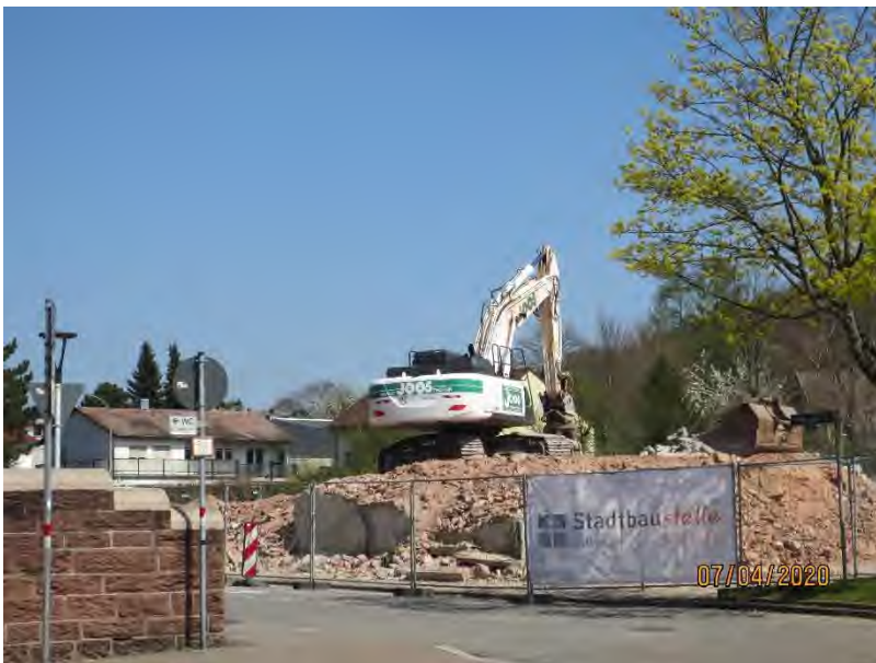
Abbildung 10: Abbruch ehemaliges Feuerwehreal
