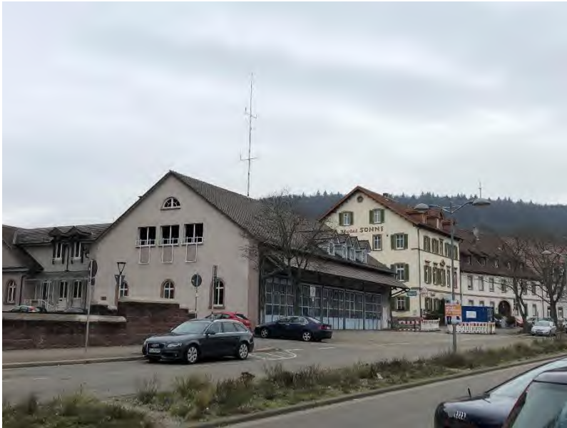
Abbildung 9: Gebäude auf dem ehemaligen Feuerwehreal (mittlerweile abgebrochen)
