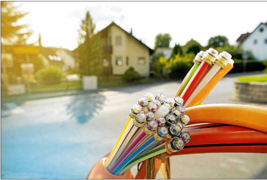
Foto: Dt. Glasfaser
