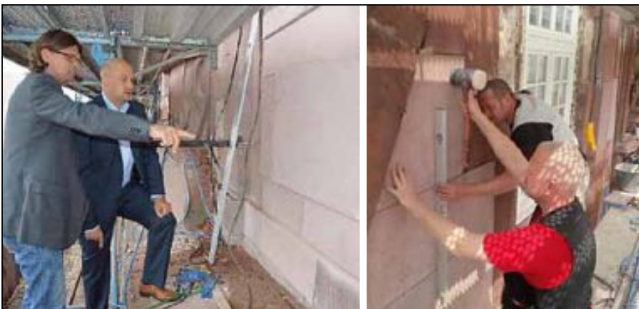
Hinter dem Vorhang: Jürgen Rother vom Hochbau zeigt OB Arnold bereits sanierte Teile der Rathausfassade (linkes Bild) die Steinmetze leisten ganze Arbeit.
