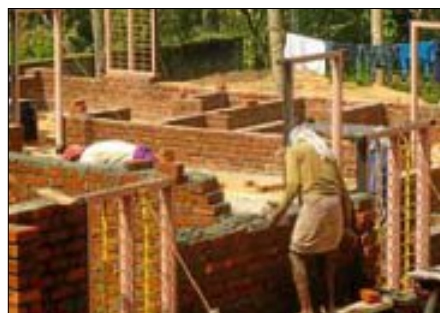
Die Bauarbeiten am Neubau der Jungenunterkunft haben deutliche Fortschritte gemacht.
