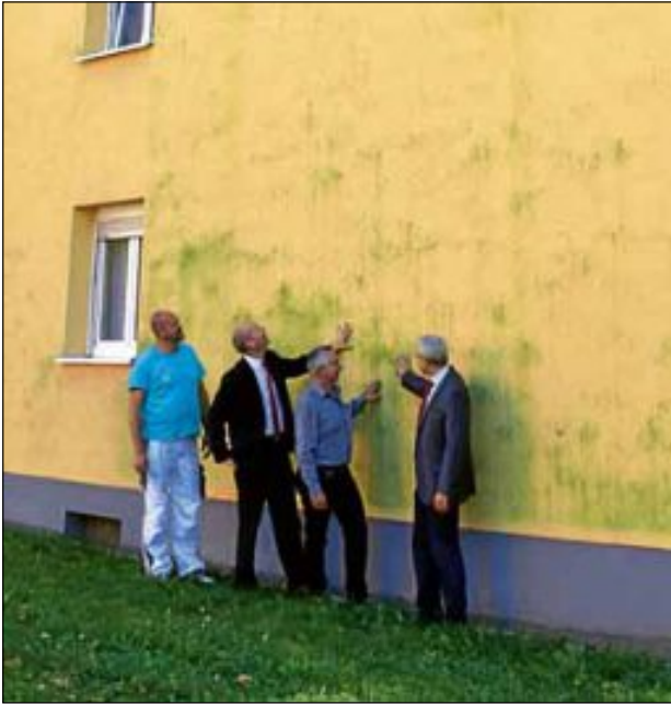
Malermeister Markus Kleemann, Stadtbau- geschäftsführer Steffen Neumeister, Stadtbau- mitarbeiter Jürgen Speck und Stadtbau-Aufsichtsrats- vorsitzender BM Thomas Fedrow inspizieren die veralgte Fassade.
