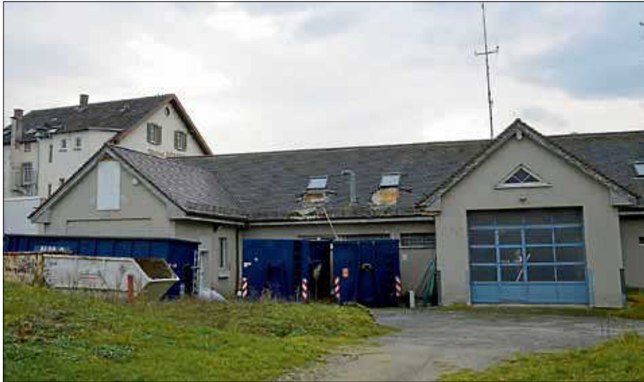
Noch steht das ehemalige Feuerwehrgebäude. Im Innern ist es bereits „ausgebeint“.
