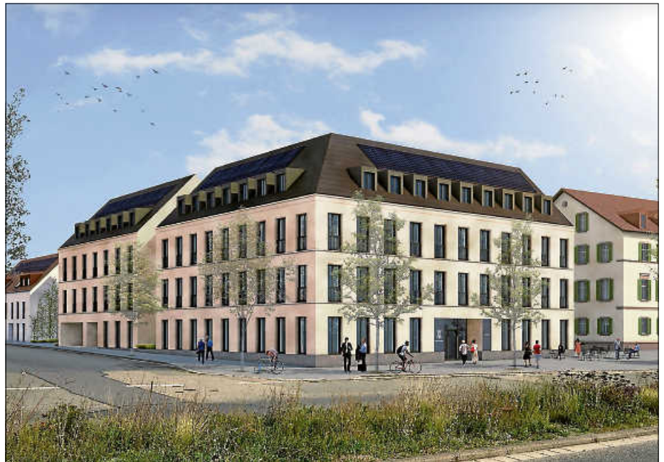
Auf dem ehemaligen Feuerwehrareal an der Pforzheimer Straße baut die Stadtbau Wohnungen. In den L-förmigen Bau wird es ein Café geben und Teile der Verwaltung werden hier einziehen.
